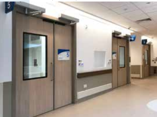
▲ Singapore - Sengkang: Stanze di isolamento, porte a battente ermetiche
