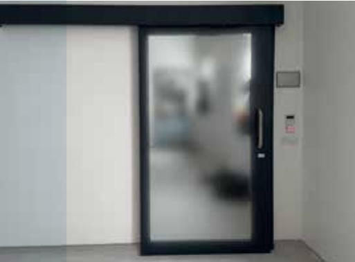
▲ Bosnie - Doboj : Bloc opératoire, Portes semi-étanches
